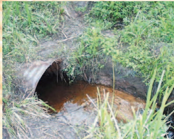
P21-2 :Collapsed Armco Pipes
