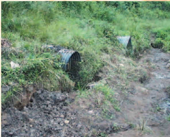
P21-2 :Collapsed Armco Pipes
