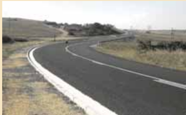
P240 : Ongoye Link Road : Km 0,7
