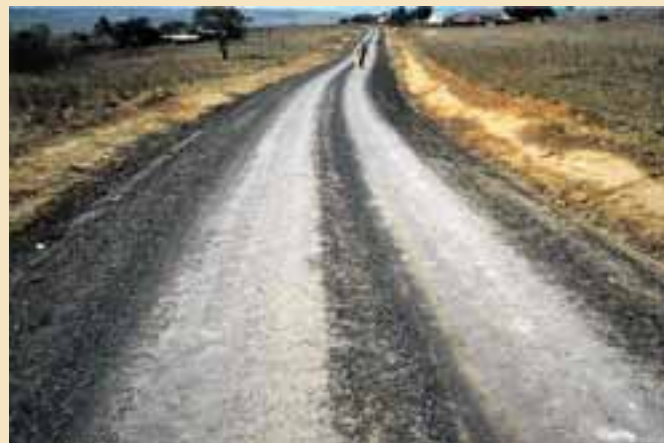
Section of Sivulindlela Local Road
