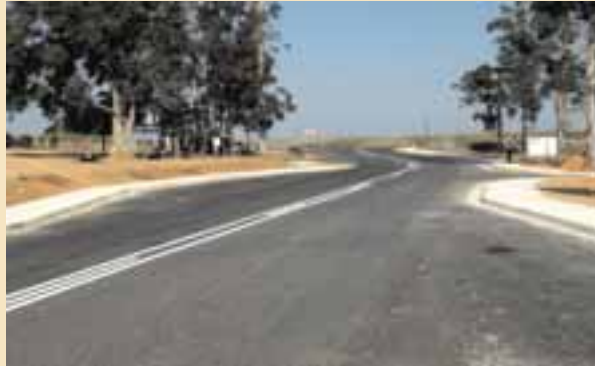
P240 : Ongoye Link Road : Start of the Project KM 0,0
